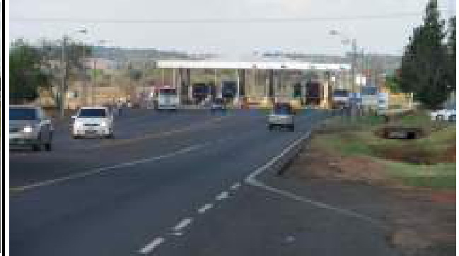
Prog. 200+000 Puesto de Peaje
