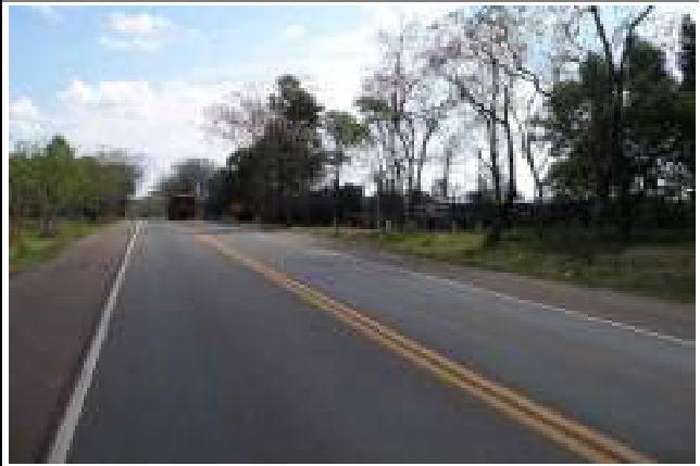
Prog. 170+000 Calzada de 2 Carriles (Adelantamiento No Permitido)
