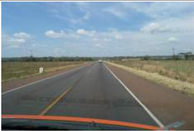
Prog. 144+000 Calzada de 2 Carriles (Adelantamiento Permitido)
