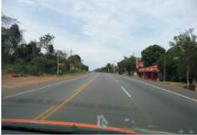
Prog. 61+000 Tramo de Carril de Ascenso
