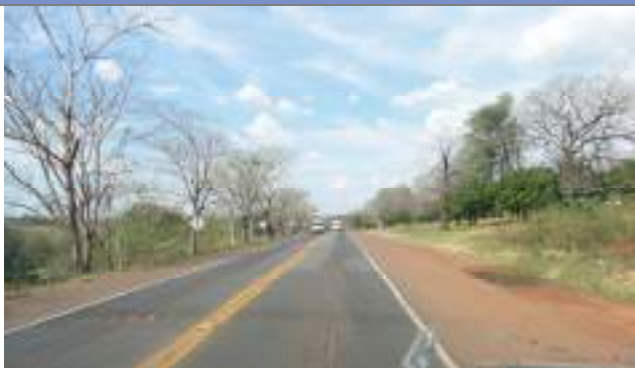
Prog. 155+000 Pavimentación de Banquina Dañada
