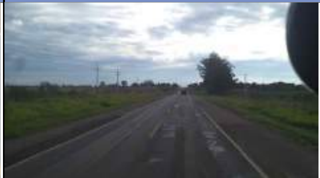
Prog. 73+000 Falta de Instalación de Barandas Protectoras en Zonas de Curvas Inversas
