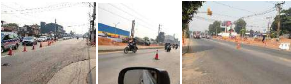
Figura 60. Desvíos en zona de obras – Tres Bocas.
