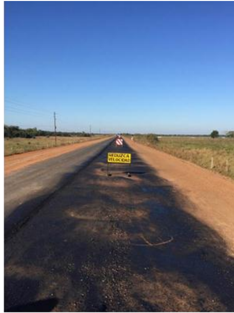
Tramo Borja – Iturbe: Obras resultantes del CM N° 2, consistente en la reconstrucción de los 11 kilómetros de pavimento tipo empedrado entre la Ruta N° 8 y la ciudad de Iturbe, profundamente dañado por las lluvias extraordinarias
