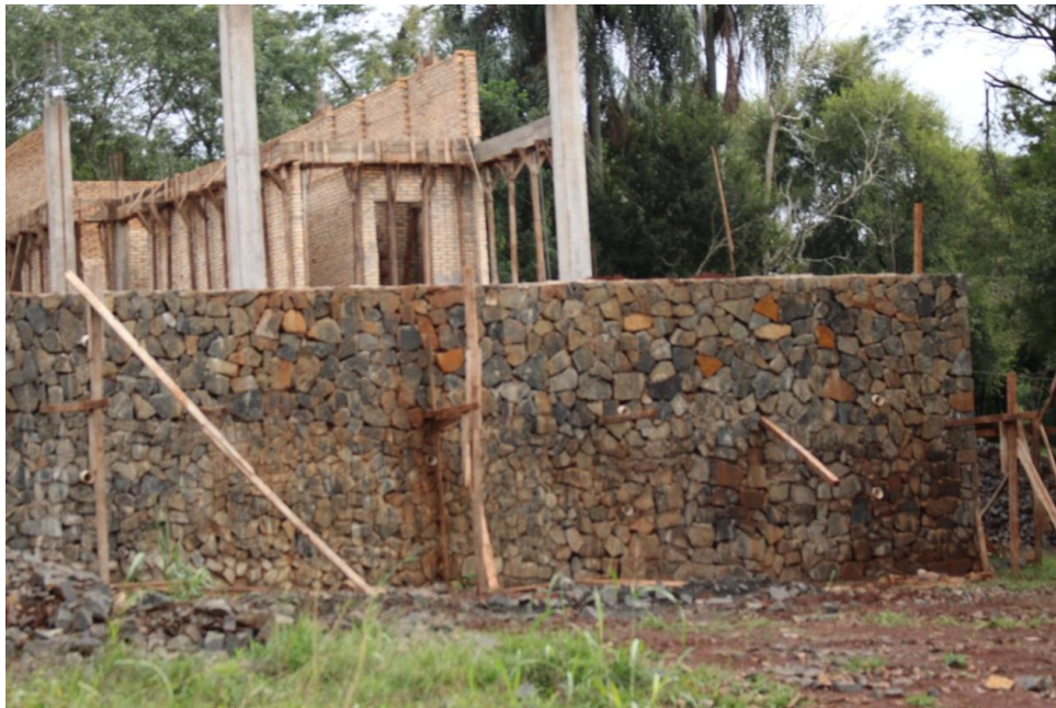
Vista de las fundaciones, sobre el cual se está ejecutando la obra
