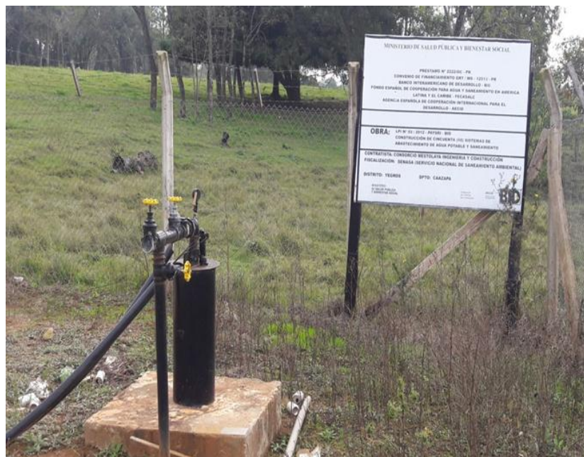
Pozo profundo, vallado perimetral, cartel de visibilidad
