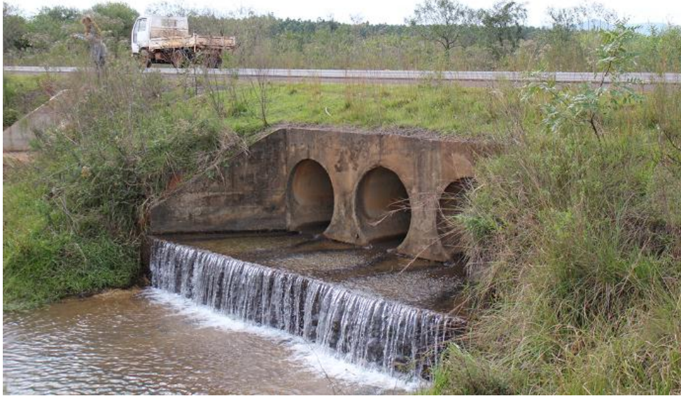
Sistema de alcantarillado tubular observado en el recorrido
