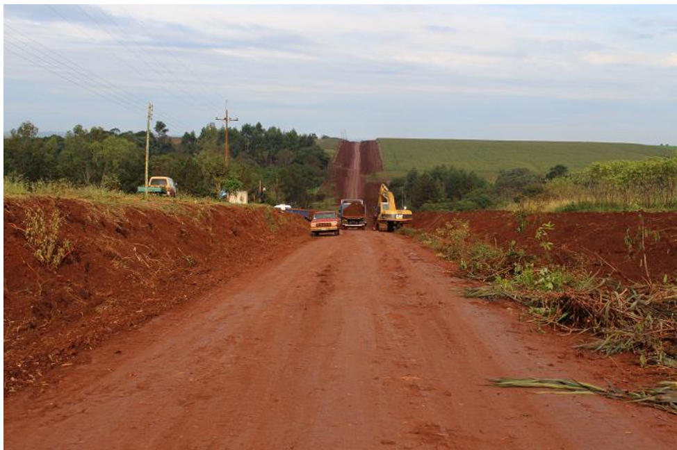
Maquinarias y camiones realizando movimiento de terraplén
