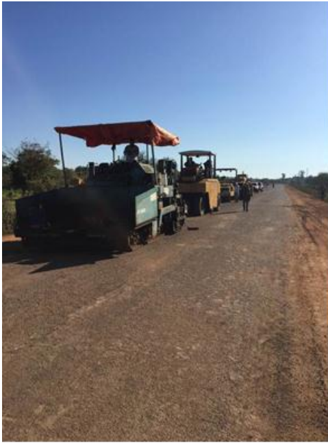
Tramo Borja – Iturbe: Obras resultantes del CM N° 2, consistente en la reconstrucción de los 11 kilómetros de pavimento tipo empedrado entre la Ruta N° 8 y la ciudad de Iturbe, profundamente dañado por las lluvias extraordinarias
