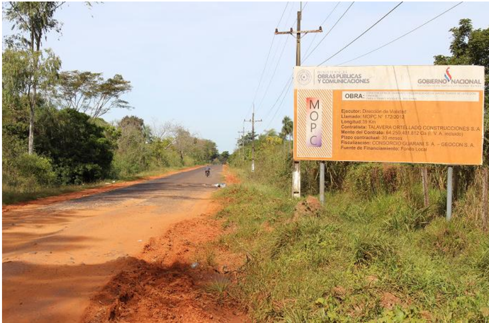
Inicio del tramo de la obra en Horqueta
