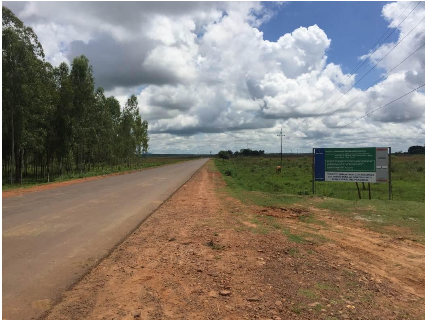
Inicio del tramo de la obra (Empalme RN N° 8)
