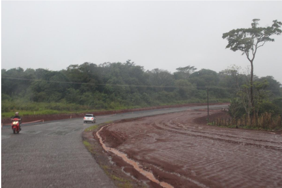
Preparación del terreno en zona de obras
