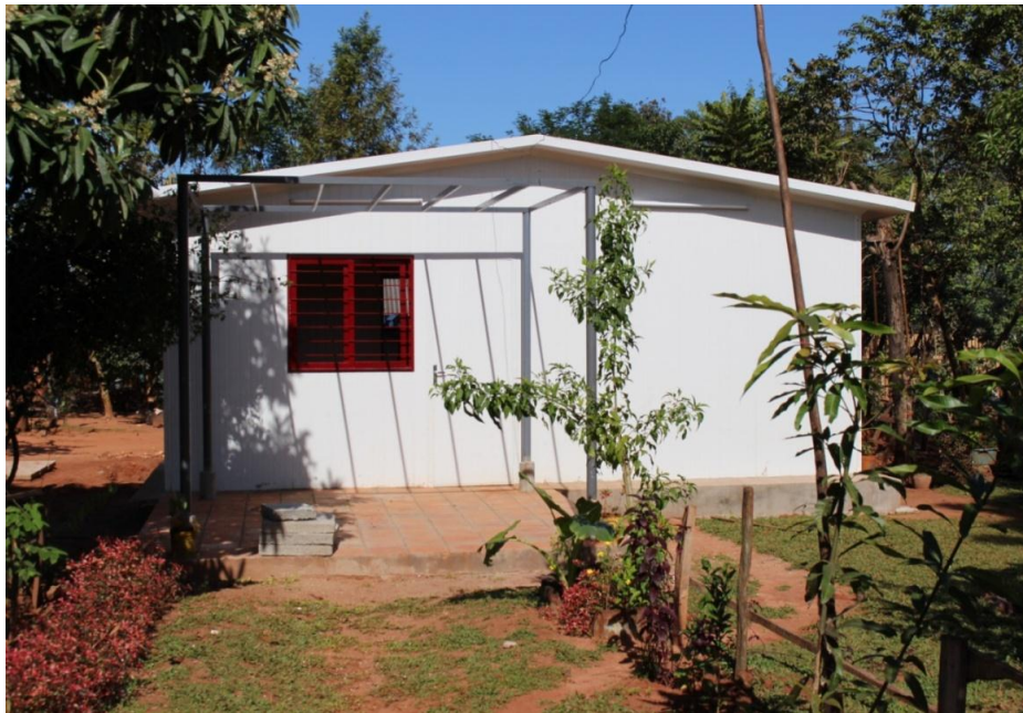
Vista frontal de la vivienda semi terminada
