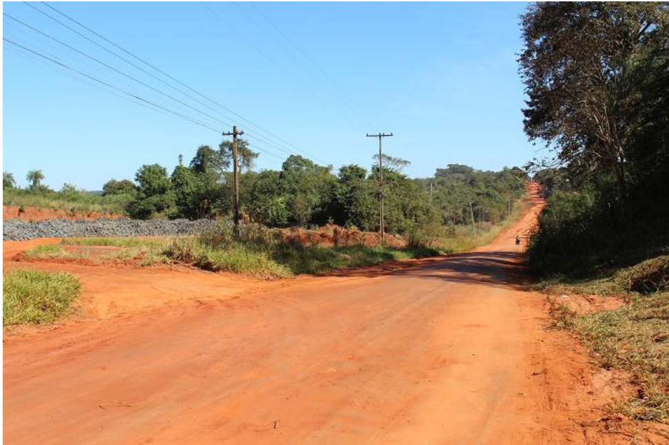
1,8 km. de camino de tierra que aún faltan empedrarse
