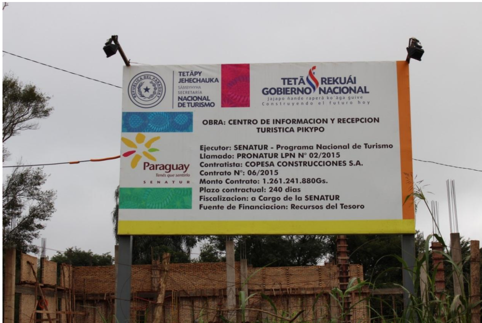
Acceso principal al futuro centro de información y recepción de visitantes
