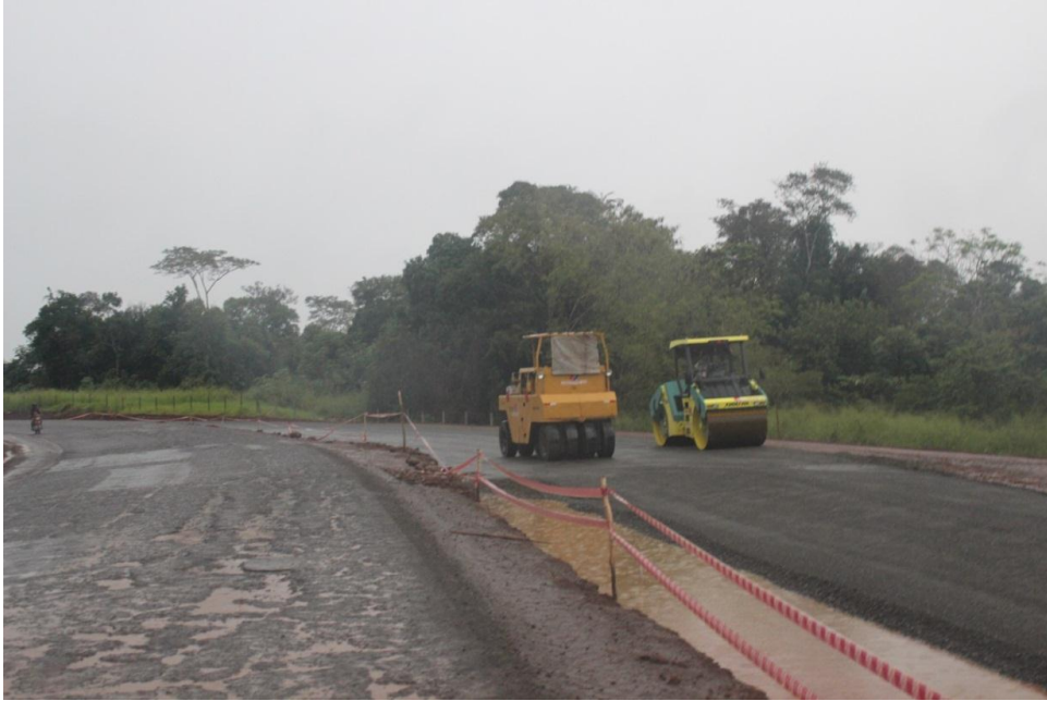
Pavimentación asfáltica de un tramo del proyecto
