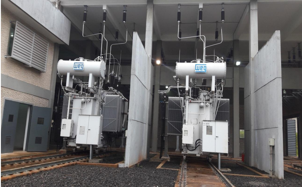
Transformadores instalados
