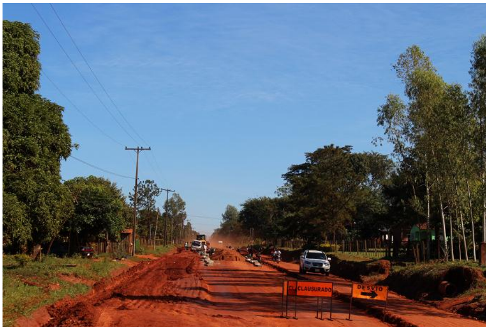
Tramo en etapa de preparación de las fundaciones sobre el cual irán los empedrados, viniendo de la calle Bertoni hacia la ruta N° 3
