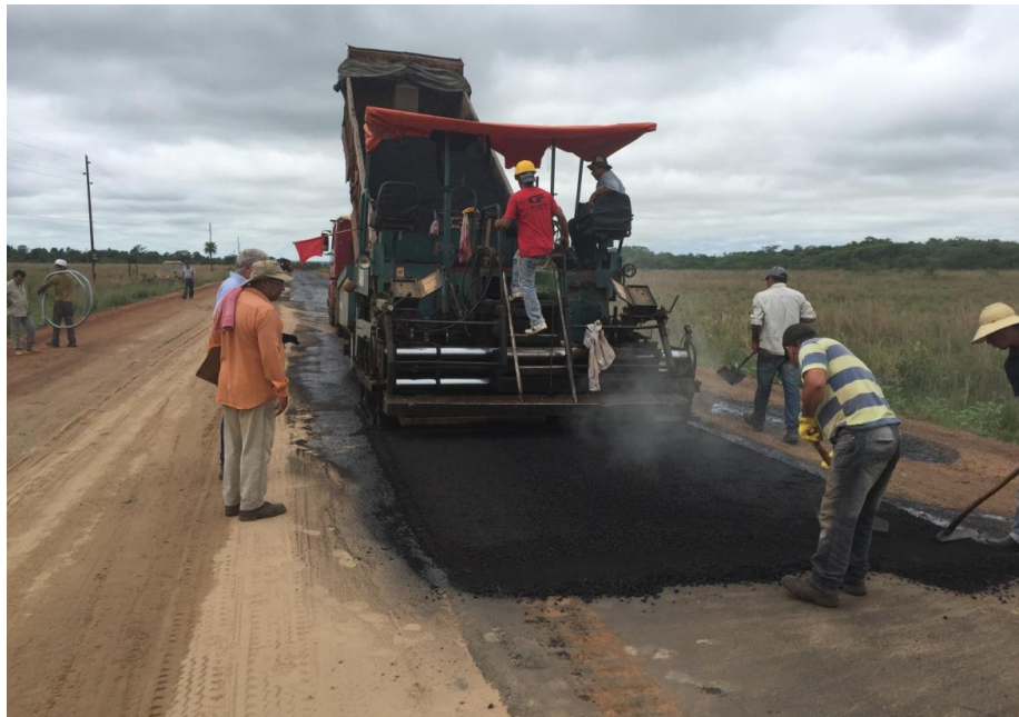
Colocación de carpeta asfáltica
