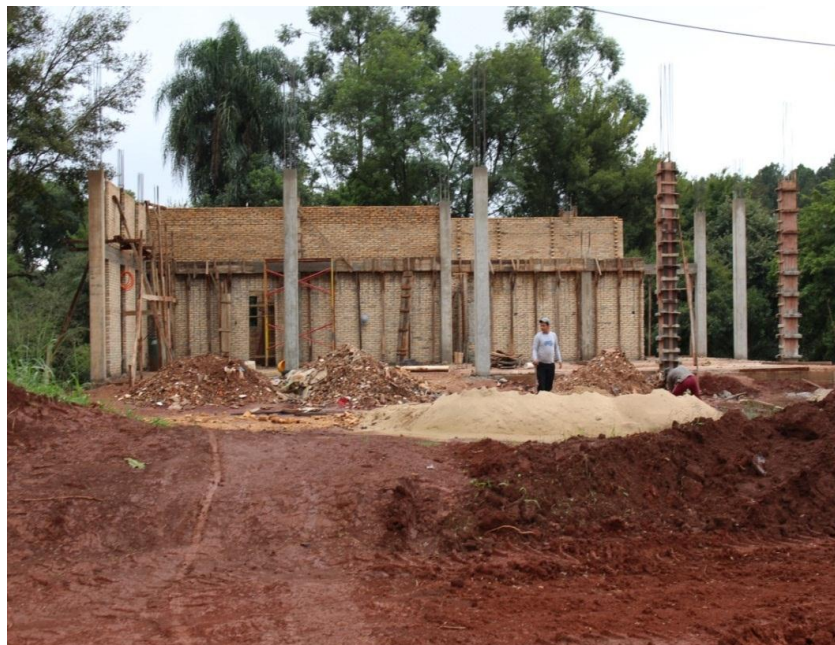
Ejecución de las obras brutas, el hormigonado de pilares y la elevación de mampostería
