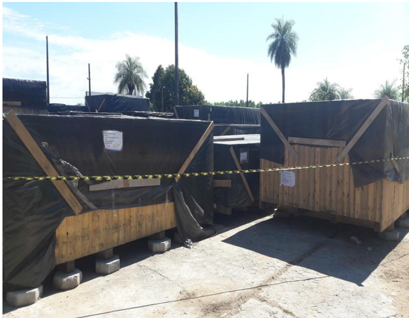
Equipos y accesorios recepcionados para la optimización de la capacidad de clínker del horno III, cambio de combustible y enfriador de clínker
