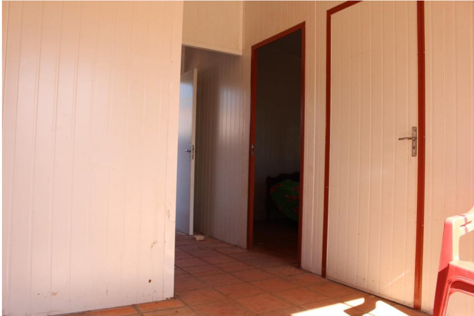
Visualización en el interior de la vivienda con pisos de layota y base de losa de hormigón y paredes de termo panel
