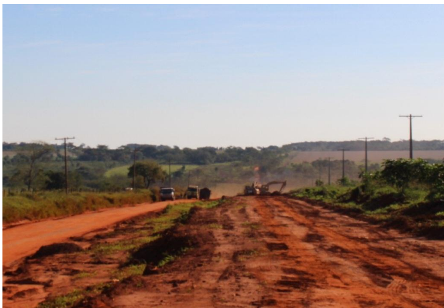
Trabajos de obreros y maquinaria en el Tramo I
