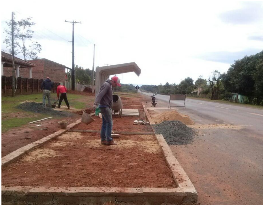
Obreros trabajando en la construcción de las obras complementarias
