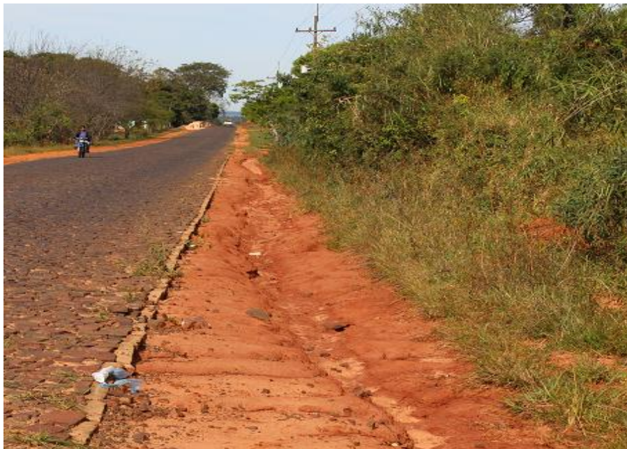
Banquinas no revestidas con tepes en algunos tramos
