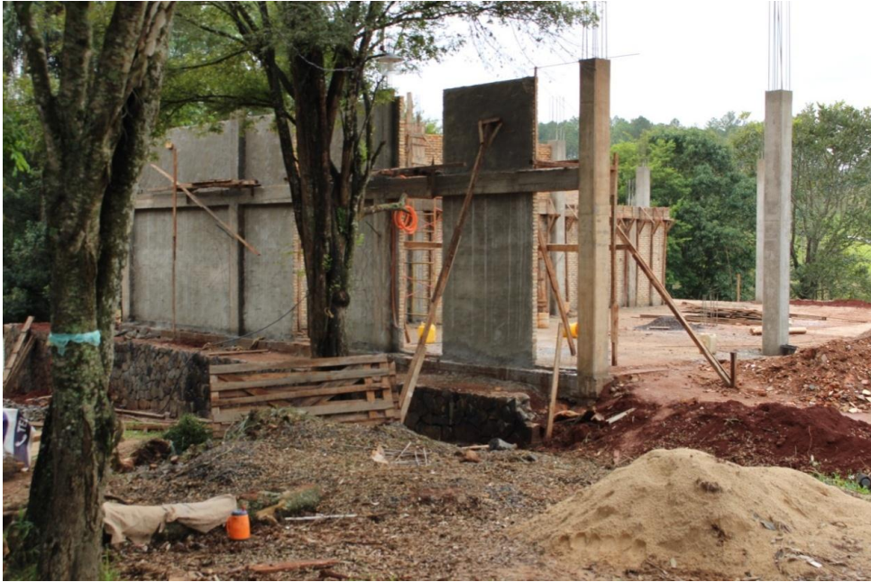
Elevación de paredes laterales de la obra
