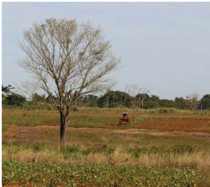
Maquinaria en operación de subsolado del terreno
